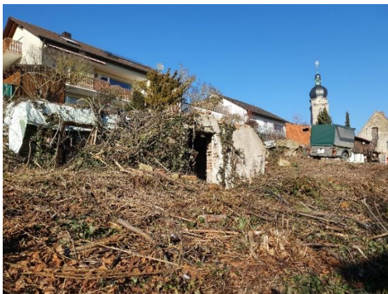
Abbildung 18: Eingang zum alten Keller
