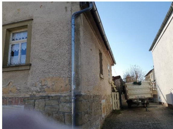
Abbildung 7: Nordseite des Gebäudes
