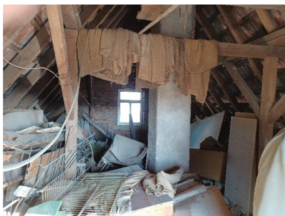
Abbildung 10: Dachgeschoss des Hauses
